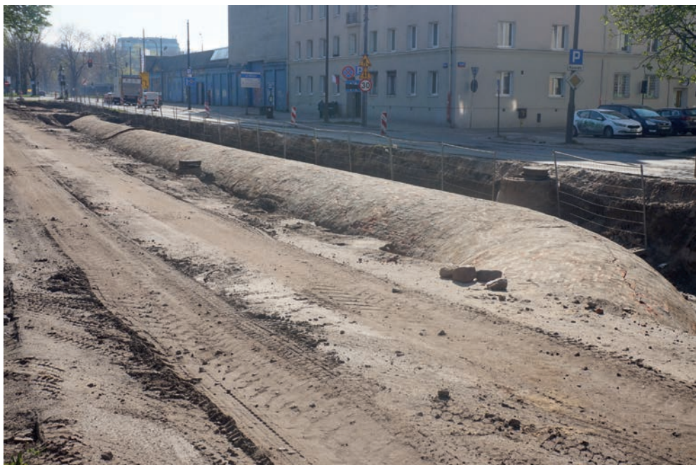
Ilustracja 20. Odslonięty w czasie prac remontowych kanał rzeki Łódki na wysokości ulic Północnej i Wolborskiej, 2022 rok Fot. Błażej Filanowski
