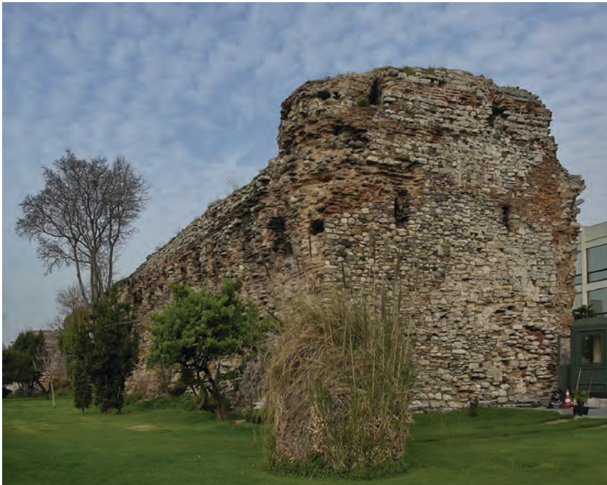
17. Pozostałości budowli w sąsiedztwie hotelu Kalyon, fot. P.Ł. Grotowski.
