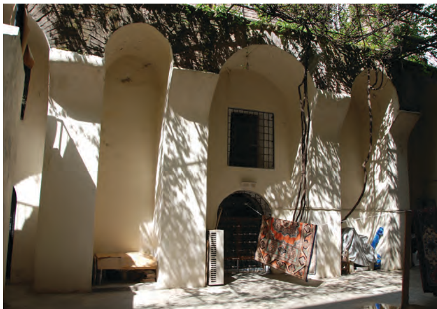
25. Taras pod kościołem Myrelajon (po 920 r.), widok od S, fot. P.Ł. Grotowski.
