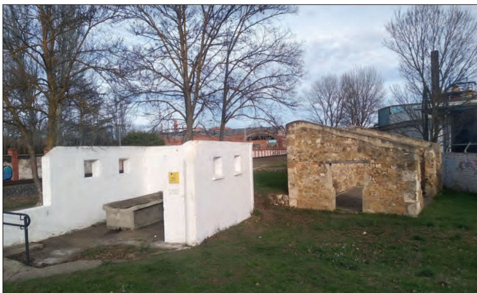
Fot. 31. Pozostałości zabudowań Campo de Concentración de Miranda de Ebro, 2022 r.
