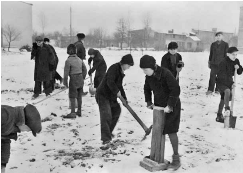
Dzieci w obozie dziecięcym przy ul. Przemysłowej pracowały bez względu na warunki atmosferyczne. Zimą dokuczał im dodatkowo brak ciepłej bielizny, kocy i ubrań. Na zdjęciu mali więźniowie budują jedną z wewnętrznych dróg w obozie, Łódź, 1942–1945 r. (IPN)
