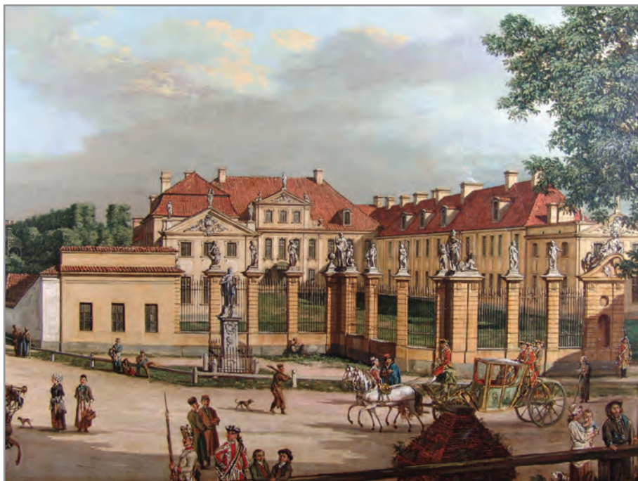
Ryc. 42. B. Bellotto, Pałac Mniszchów w Warszawie (Zamek Królewski w Warszawie), fot. J. Sito, 2016
