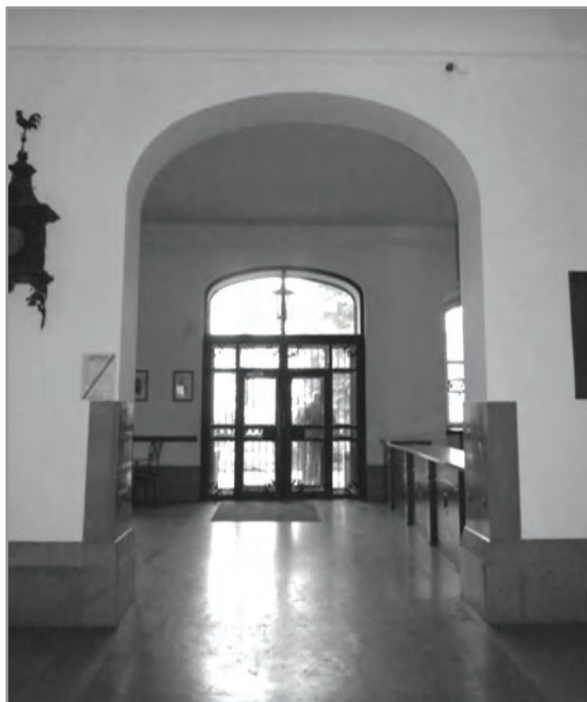
Ryc. 165. Pałac Mniszchów przy ul. Miodowej – wielka sień, fot. A. Barczyk, 2015
