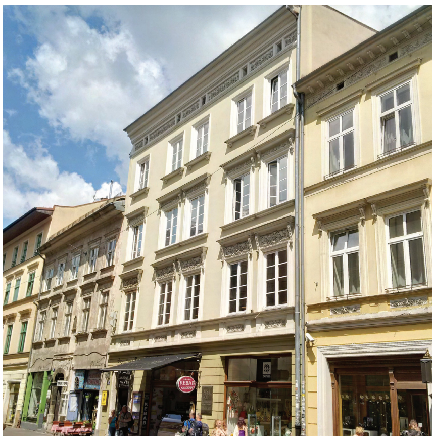
Fot. 2. Kraków, Kamienica przy ul. Szewskiej 21. Całe trzecie piętro zajmowało mieszkanie Piotra Stachewicza z pracownią malarską od podwórza. Na drugim piętrze, po prawej, dwa okna dawnego pokoju Melchiora Wańkowicza, później mieszkania Ewy Siedleckiej, jeszcze później – autorów artykułu, fot. R. Godula-Węclawowicz, 2023 r.
