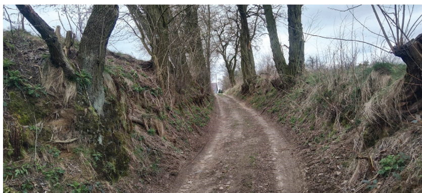
Fot. 10. Rozcięcie drogowe w Dąbrówce Małej (gm. Brzeziny) – droga dojazdowa do Młyna nad Mroźycą Źródło: archiwum ZPKWŁ
