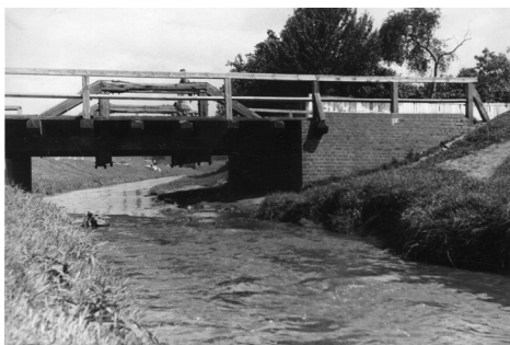
Fot. 1. Rzeka Łódka, most przy ul. Pryncypalnej (obecnie ul. Odolanowska) (1936 r.)
