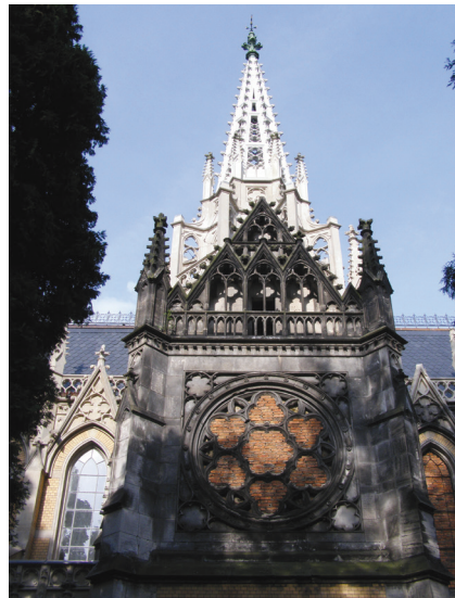
Fot. 10. Mauzoleum K. Scheiblera w trakcie prac renowacyjnych – stan w 2012 roku
