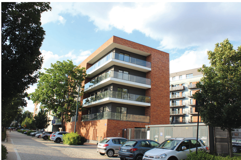
Fot. 14. Nowe, zamknięte Osiedle Legionów 66 przy skrzyżowaniu z ul. Pogonowskiego. Widok od strony południowej Źródło: fot. B. Dzięcioł-Kurczoba
