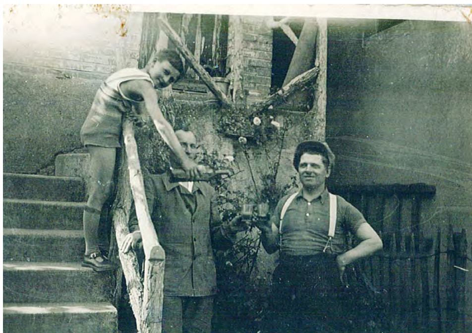
Fot. 4. Prace budowlano-remontowe na Bałutach. Lata 30. XX w. Własność Autorki.
