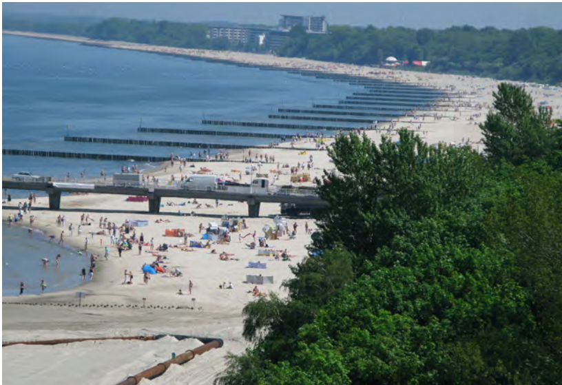
Ryc. 4.25. Prace sprzyjające gromadzeniu piasku na plaży w Kołobrzegu. Na pierwszym planie dowóz piasku, a na drugim drewniane ostrogi wymuszające akumulację
