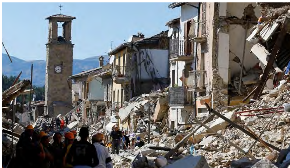
Ryc. 2.6. Zniszczone budynki w centrum Amatrice w środkowych Włoszech, 24.08.2016 r.
