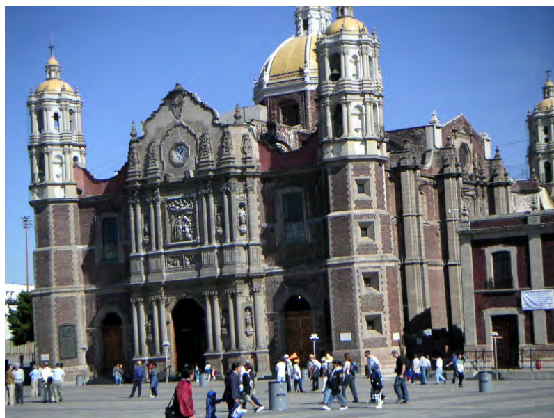
Ryc. 5.13. Przechylenie bazyliki Matki Bożej z Guadalupe w Meksyku w wyniku osiadania terenu
