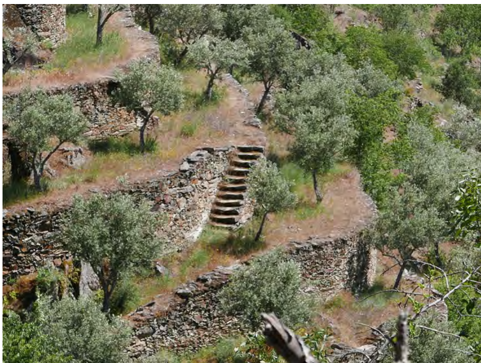
Ryc. 7.19. Antropogeniczne terasy skutecznie chronią zbocze przed spłukiwaniem
