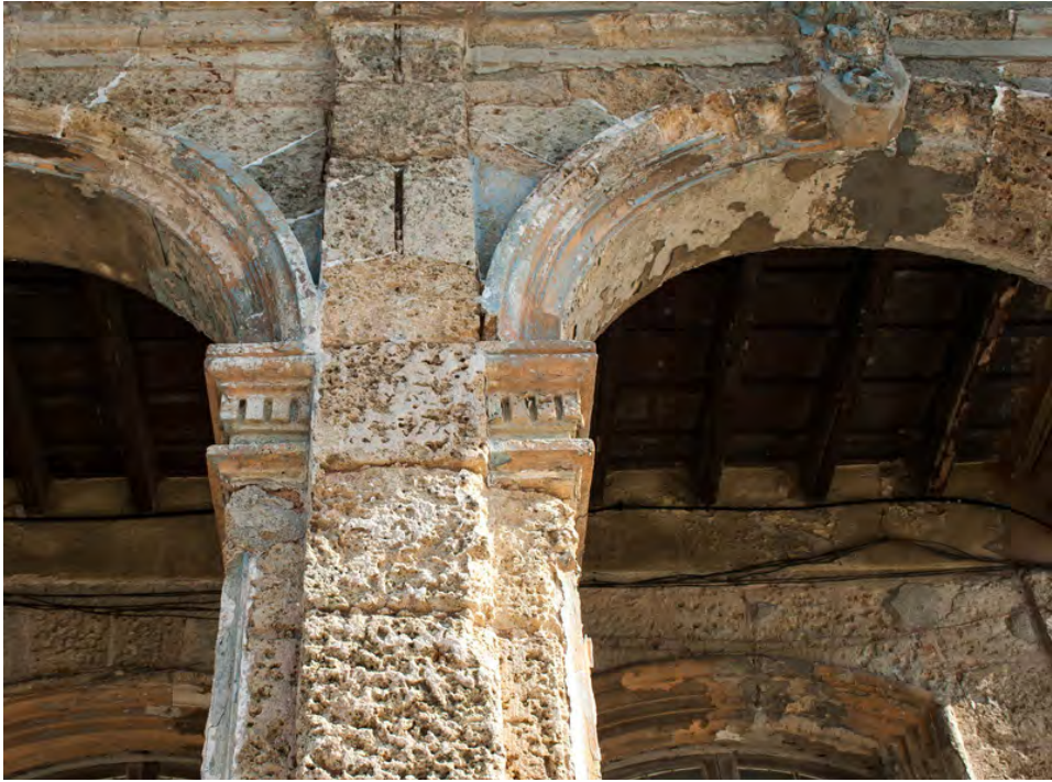
Ryc. 8.10. Budynki wzniesione z piaskowca podlegające wietrzeniu solnemu i kawernizacji w starej Hawanie
