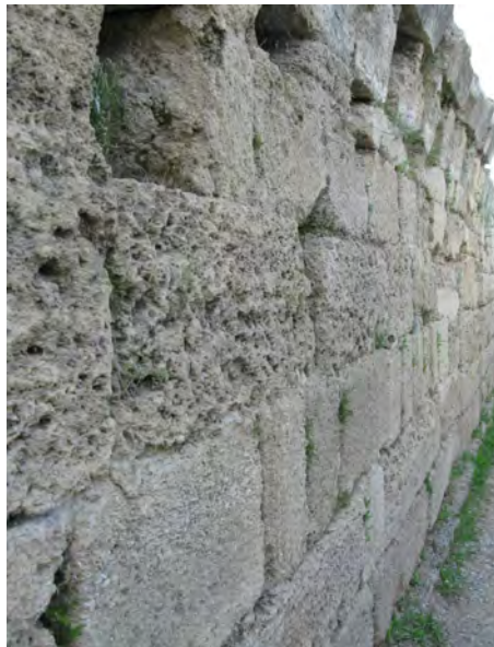
Ryc. 8.3. Powierzchnia muru wapiennego podlegająca wietrzeniu mrozowemu
