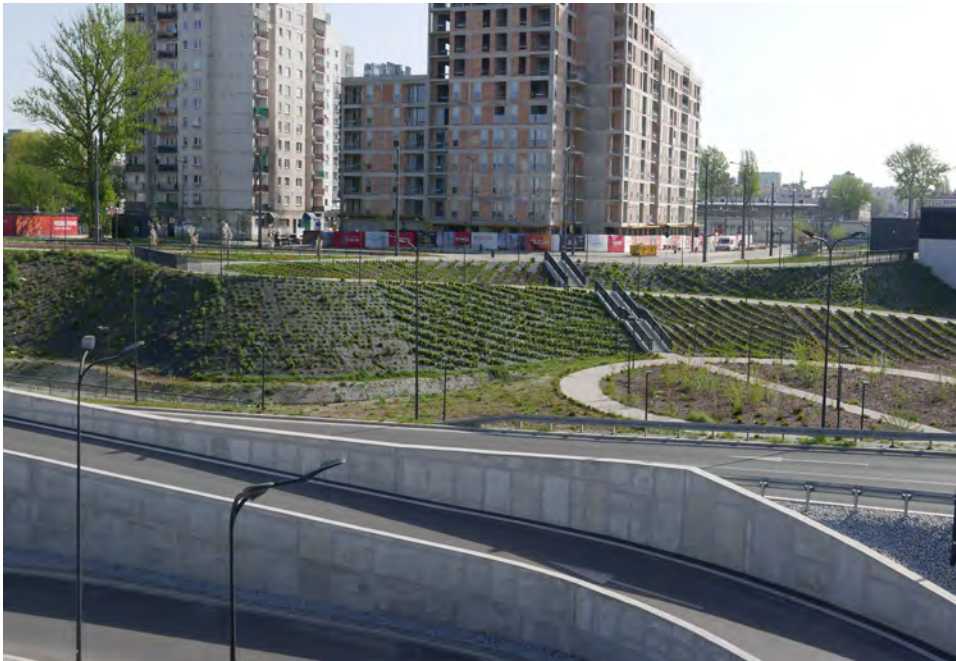
Ryc. 7.20. Antyerozyjne zabezpieczenia skarp z zazielenieniem
