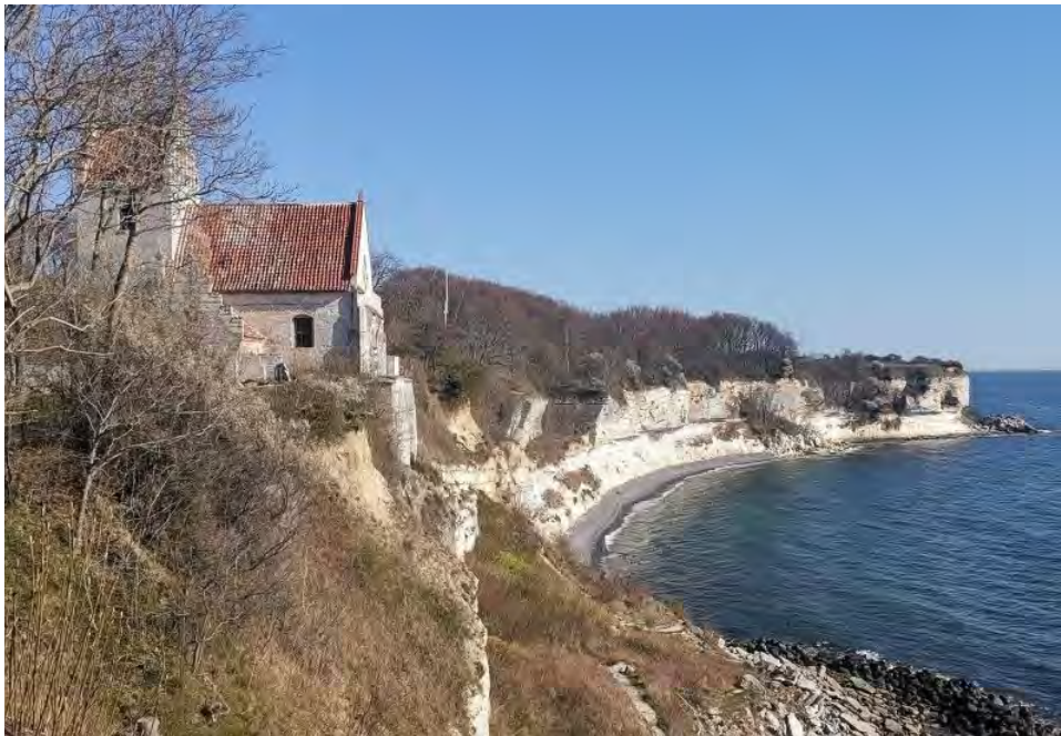
Ryc. 4.20. Budynek kościoła Højerup w Danii na krawędzi klifu zbudowanego z kredy piszącej w spągu i wapieni w stropie
