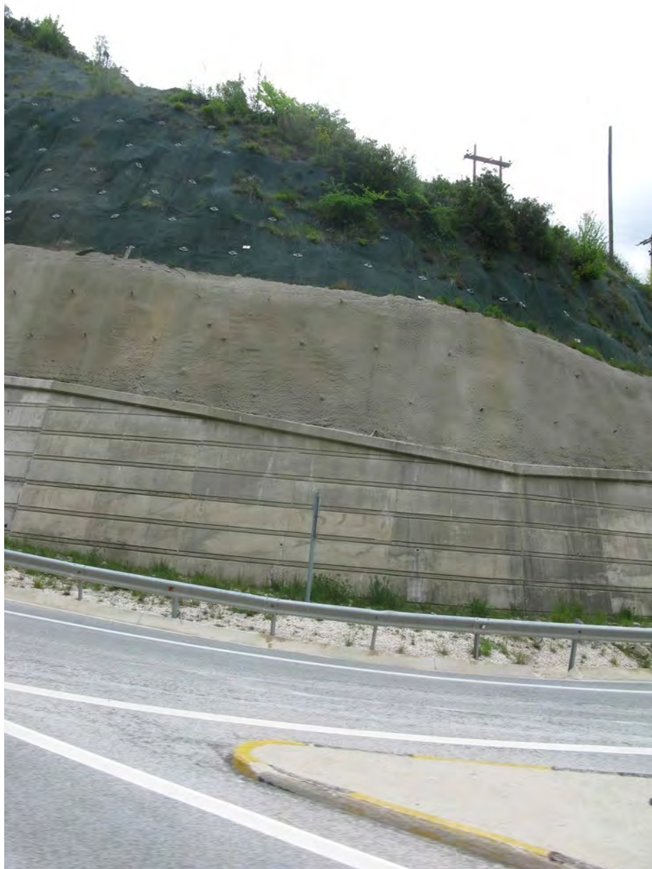
Ryc. 7.7. Stok zabezpieczony przed odpadaniem – w dolnej części mur oporowy, a w górnej siatki
