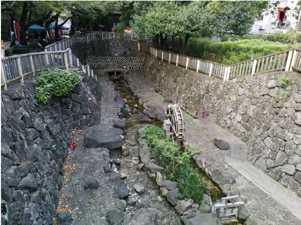
Ryc. 6.20. Mała rzeka w Tokio wykorzystywana jako kanał odpływu wód opadowych oraz miejsce spacerowe przy niskich stanach wody
