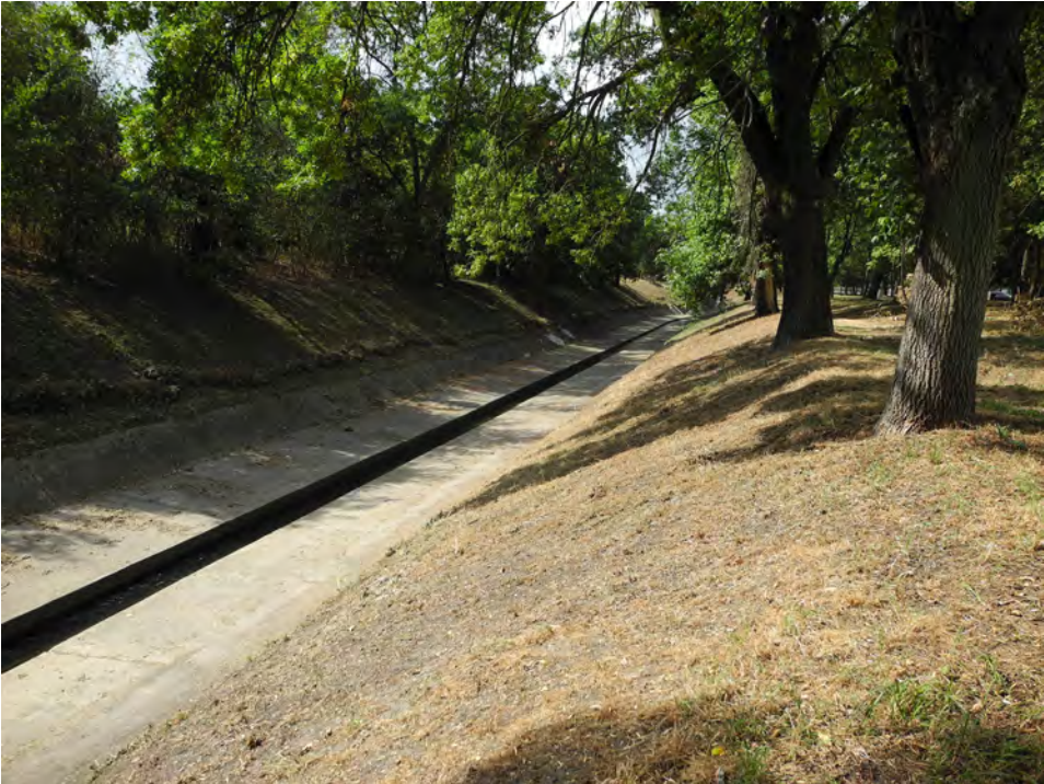
Ryc. 6.19. Koryto małej rzeki ukształtowane tak, aby mogło przyjąć wszystkie wody wezbraniowe, przykład Jasienia w Łodzi w strefie zabudowy jednorodzinnej
