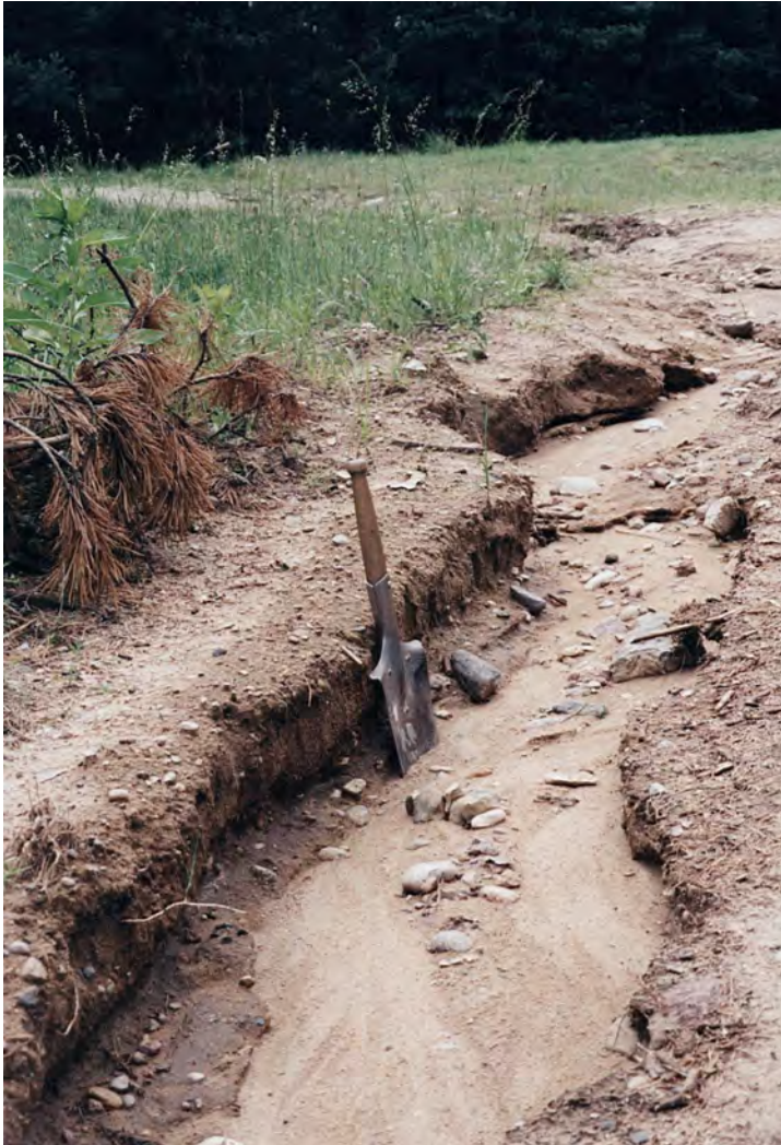
Ryc. 7.18. Bruzda deszczowa powstała po dwugodzinnym opadzie na poboczu drogi zbudowanej z luźnych osadów
