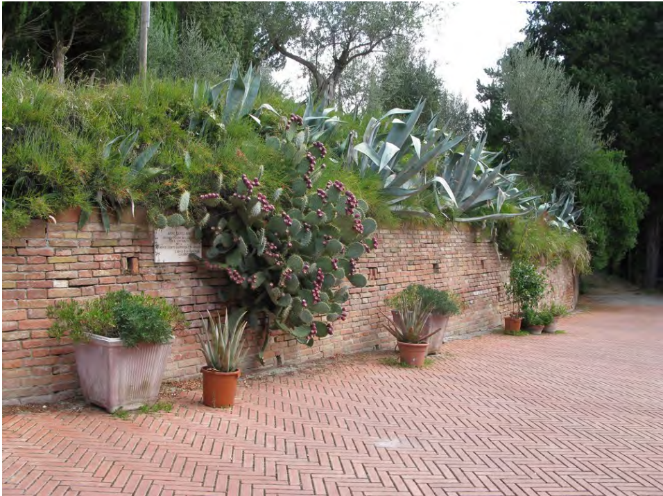
Ryc. 7.17. Niski mur oporowy zabezpieczający parking – w murze widoczne są okienka umożliwiające wypływanie wód gruntowych podczas opadów
