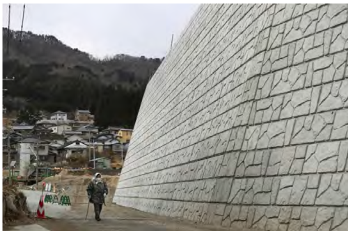
Ryc. 2.11. Ściana o wysokości 14 m chroniąca nisko położone części wybrzeża przed tsunami w Japonii
