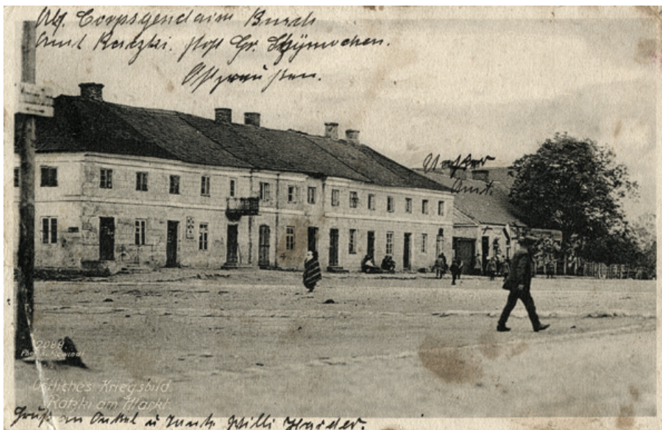
II. 3. Rynek w Raczkach. Kamienica z lat 20. XIX w. oraz budynek urzędu z 1909 r. Rok 1915
