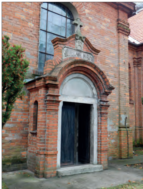
Ryc. 4. Wejście do krypty Żółtowskich, fot. E.P., 2020 r.
