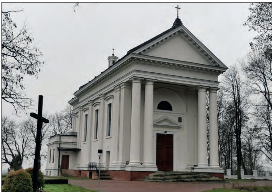
Ryc. 2. Kościół fundacji Róży z Potockich Krasińskich z lat siedemdziesiątych XIX w., który zastąpił rotundę. Kaplica grobowa Krasińskich rozciąga się pod całą długością kościoła, stanowiąc z kościołem jedną bryłę, fot. W.J. Górczyk
