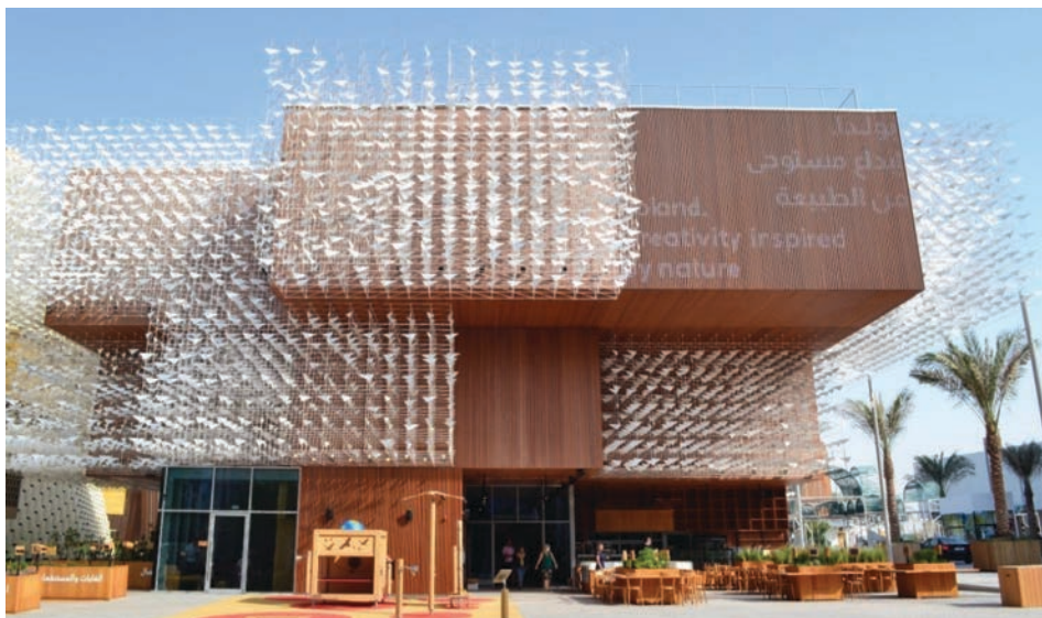
Fotografie 4. Budynek Pawilonu Polskiego na Expo 2020 w Dubaju
