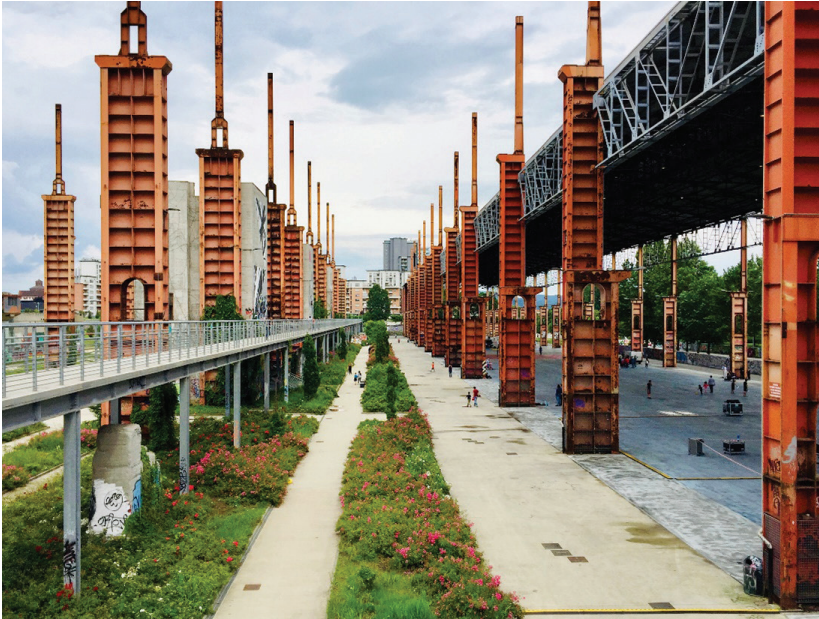
Fotografia 7. Parco Dora, Turyn, Włochy: „las” filarów, czyli elementów konstrukcyjnych pozostawionych po wcześniejszych zabudowaniach przemysłowych
