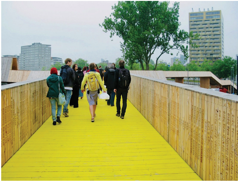
Fotografia 10. Luchtsingel, Rotterdam, Holandia: kładka piesza powstała z inicjatywy oddolnej mieszkańców fachowców
