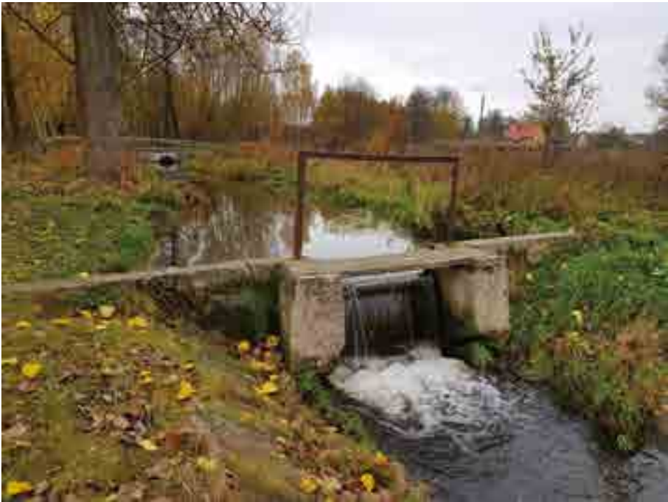
Fot. 7.8. Zastawka i przepust drogowy na Dobrzyńce
