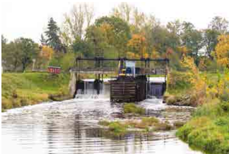
Fot. 2.5. Najstarsza elektrownia wodna na Nerze w Kolonii Borek
