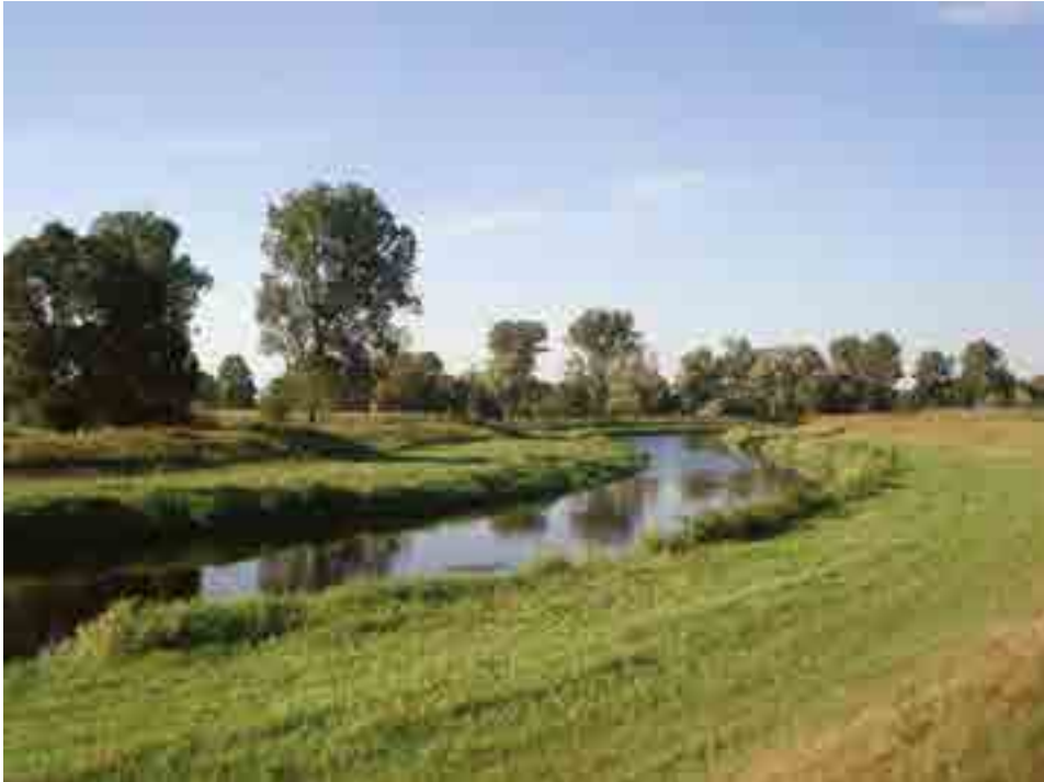
Fot. 2.6. Ner w Parskach. Widoczny prawostronny wał przeciwpowodziowy
