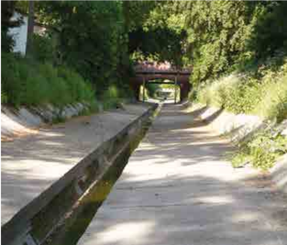
Fot. 2.11. Betonowy kanał Jasienia w Łodzi
