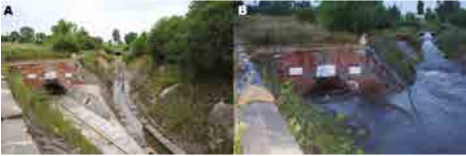
Fot. 2.12. Karolewka i uchodzący do niej przelew burzowy w okresie bezopadowym (A) i po opadach (B) w 2008 roku
