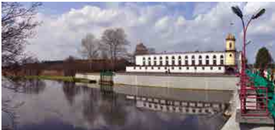
Fot. 7.5. Ujęcie wody z Pilicy pod Tomaszowem Mazowieckim
