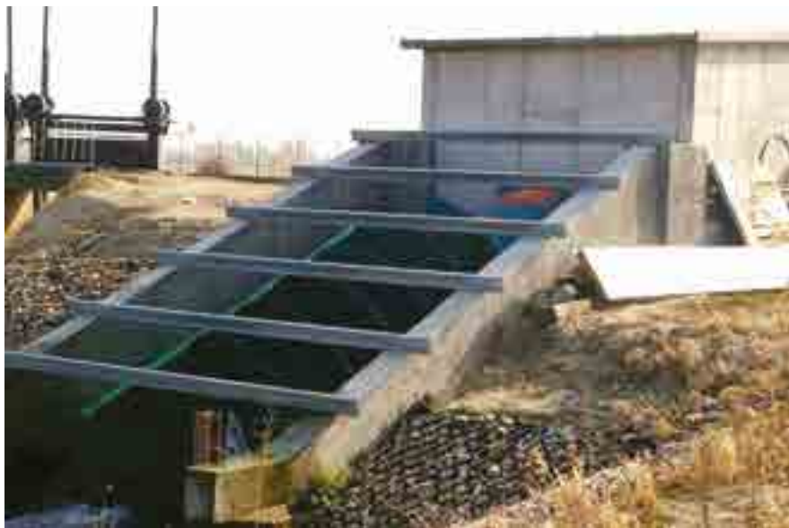
Fot. 9.3. MEW w Zygmontowie ze śrubą Archimedesą w kanale obiegowym
