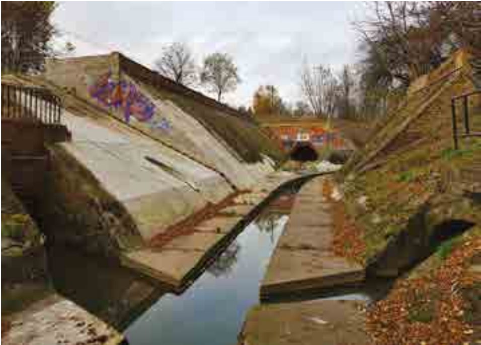
Fot. 8.4. Koryto Karolewki z wylotami przelewów burzowych
