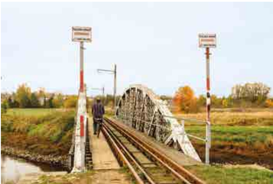
Fot. 2.2. Most tramwajowy na Nerze pod Lutomierskiem
