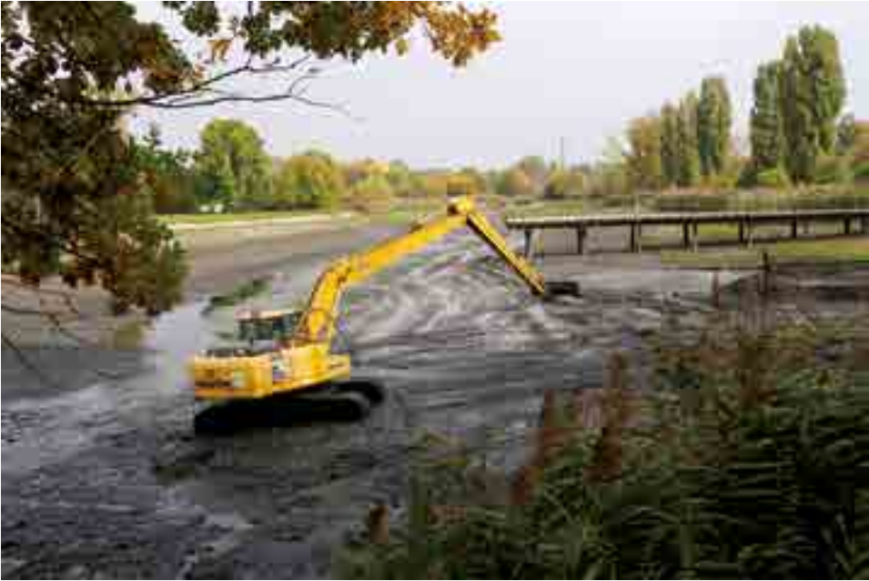
Fot. 2.29. Usuwanie osadu ze stawu Księży Młyn
