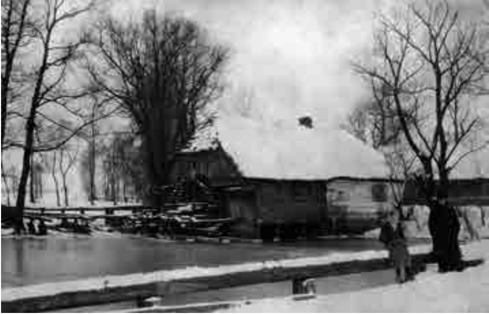
Fot. 2.21. Nieistniejący już dziś młyn na Pisi I w Wodzieradach-Leśnicy w 1916 roku
