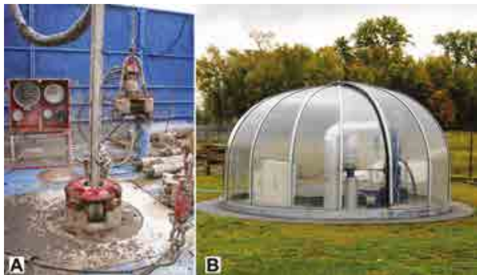
Fot. 1.1. Odwiert wydobywczy GT-2 w Poddębicach: A – podczas drążenia; B – stan w październiku 2019 roku
