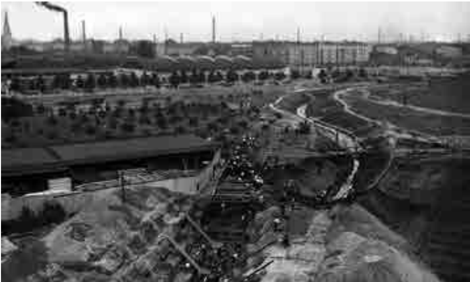
Fot. 2.10. Stare koryto i nowy kanał Dąbrówki przy placu Niepodległości
