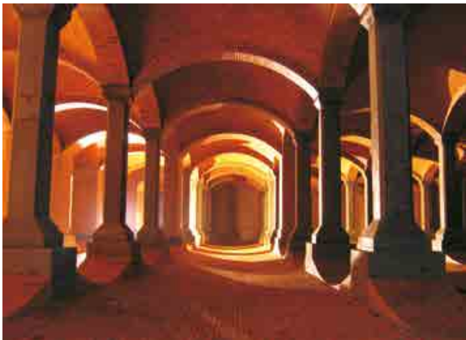
Fot. 7.3. Wnętrze zbiorników wody czystej na Stokach
