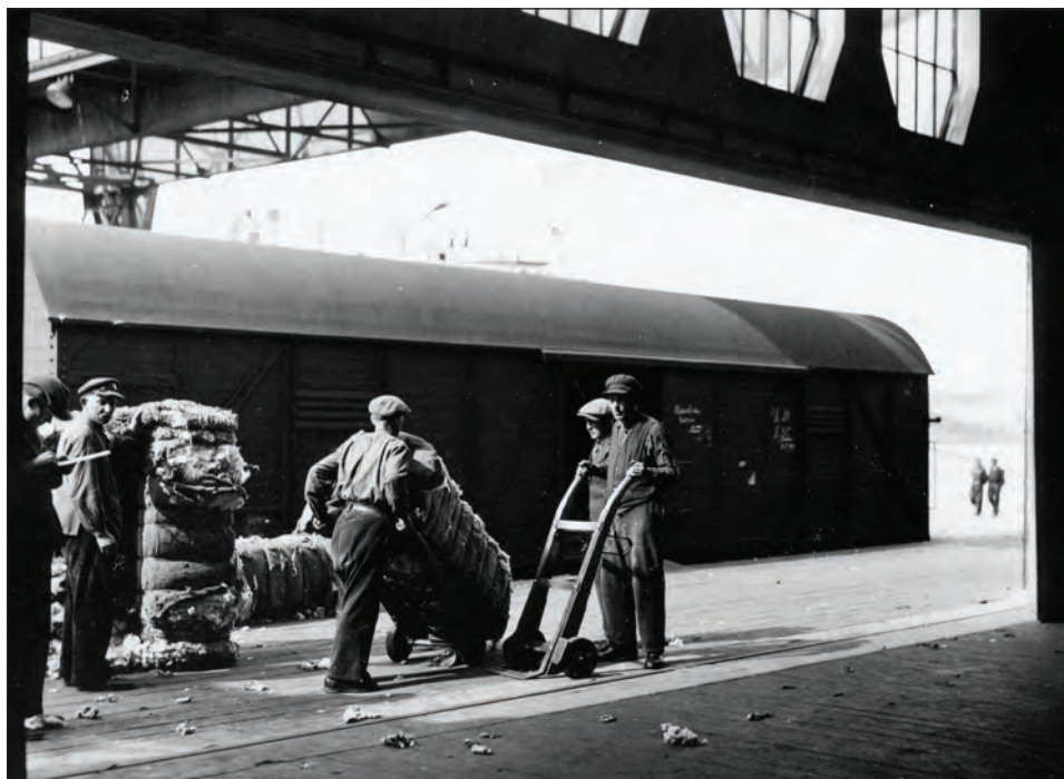
Fot. 4. Przeładunek bawełny ze statku do magazynu w gdyńskiej Strefie Wolnocłowej. Źródło: NAC, IKC, sygn. 1-G-4933
