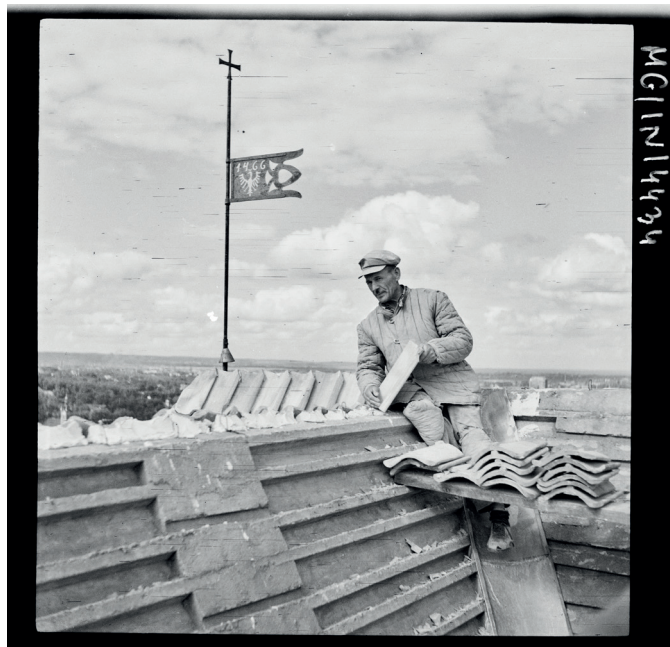
Ryc. 5. Negatyw czarno-biały ukazuje dekarza podczas układania dachówki. Czas powstania fotografii: po 1945 r., fot. Kazimierz Lelewicz, zbiory Muzeum Gdańska, numer inwentarzowy: MG/IN/4434 (źródło opisu http://dziedzictwo-gdansk.pl/record/-/record/display/manifestation/RECORD20799/90e7680b-9b59-4543-b361-002a95a9f2bd/solr/0/12/0/1/score/DESC , dostęp: 20 X 2020)
