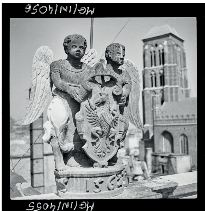
Ryc. 1. Negatyw czarno-biały ukazuje detal architektoniczny znajdujący się na attyce ratusza Głównego Miasta Gdańskiego. Detal przedstawia dwa anioły (po uzupełnieniu ubytków), trzymające kartusz herbowy. W tle po prawej stronie widoczna wieża kościoła Mariackiego. Czas powstania fotografii: po 1945 r., fot. Kazimierz Lelewicz, zbiory Muzeum Gdańska, numer inwentarzowy: MG/IN/4055 (źródło opisu: http://dziedzictwo-gdansk.pl/record/-/record/display/manifestation/RECORD20043/3892c4bc-3f7c-4e06-b41b-535ab52f3196/solr/0/12/0/1/score/DESC , dostęp: 12 X 2020)
