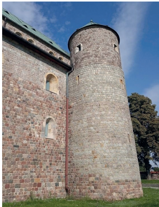
Ryc. 7. Mury kolegiaty w Tumie pod Łęczycą zbudowane z ociosanego kamienia polnego, czyli eratyków
