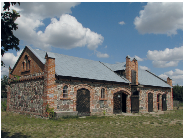
Ryc. 8. Kamienie eratyczne w konstrukcji ścian budynków na ziemi łowickiej
