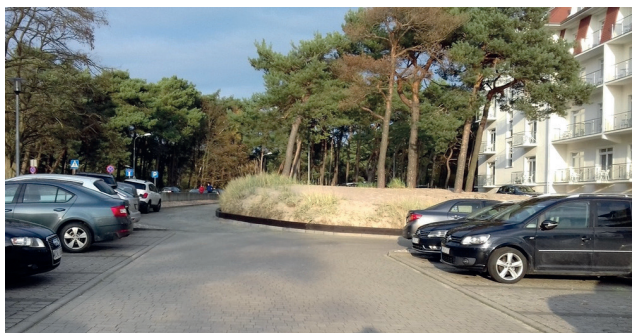
Ryc. 106. Ogrodzony fragment wydmy zniszczonej podczas budowy hotelu i parkingu w Łebie
