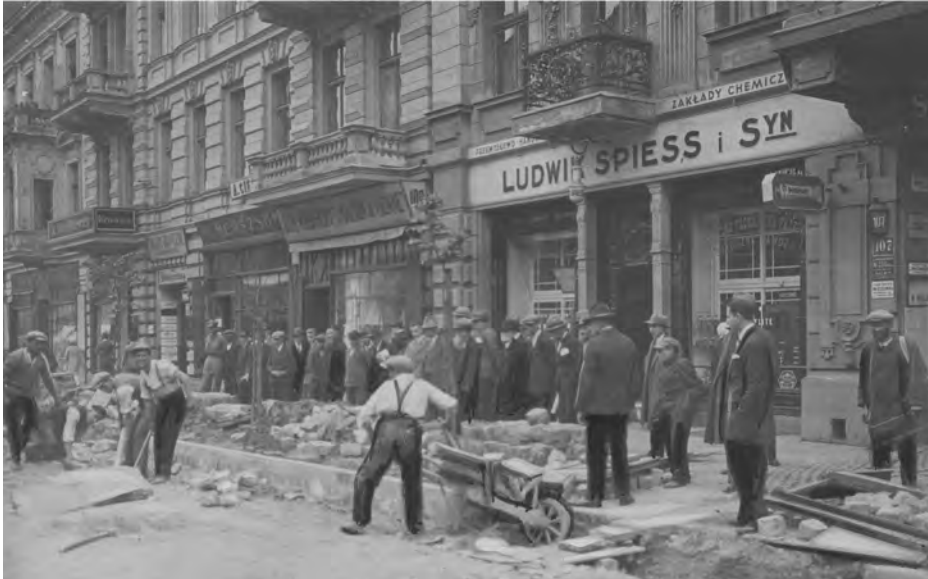
Figure 30. Installation of the sewerage system on Piotrkowska Street, author: unknown, 1929, Narodowe Archiwum Cyfrowe, Ilustrowany Kurier Codzienny – Archiwum Ilustracji, 1-G-6598.
